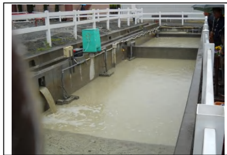
馬場から流れ出る白濁水を貯める沈殿槽
