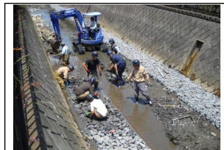
水質改善が期待されるジャカゴの設置
