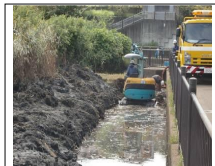
9月、広袴調整池で浚渫が行われる
