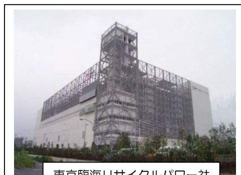
東京臨海リサイクルパワー社のガス化溶解等発電施設
